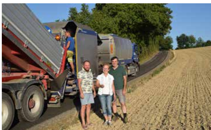
Befestigung des Radweges beim Schrickler Bründl
