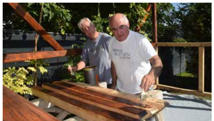
Generalsanierung der Pergola und Bänke beim Kaiserplatzl
